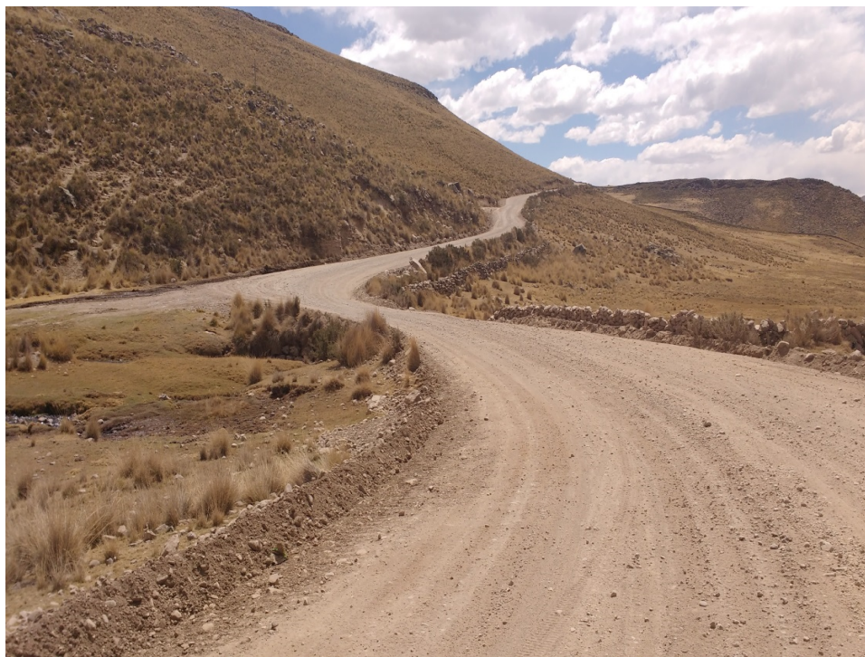
PERFILADO Y ACABADO FINAL
