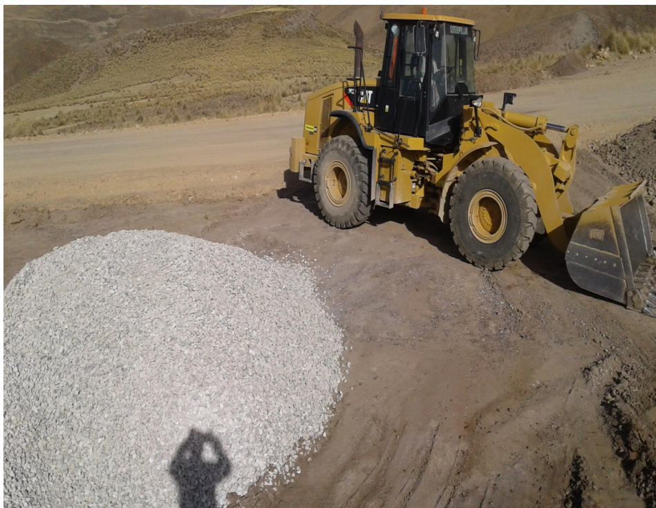
ACUMULACION DE MATERIAL CON PIEDRA CHANCADA
