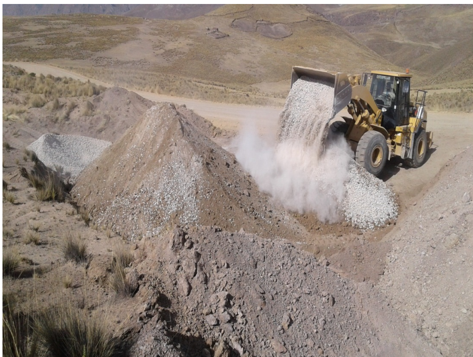
MEZCLA DE MATERIAL EN CANTERA
