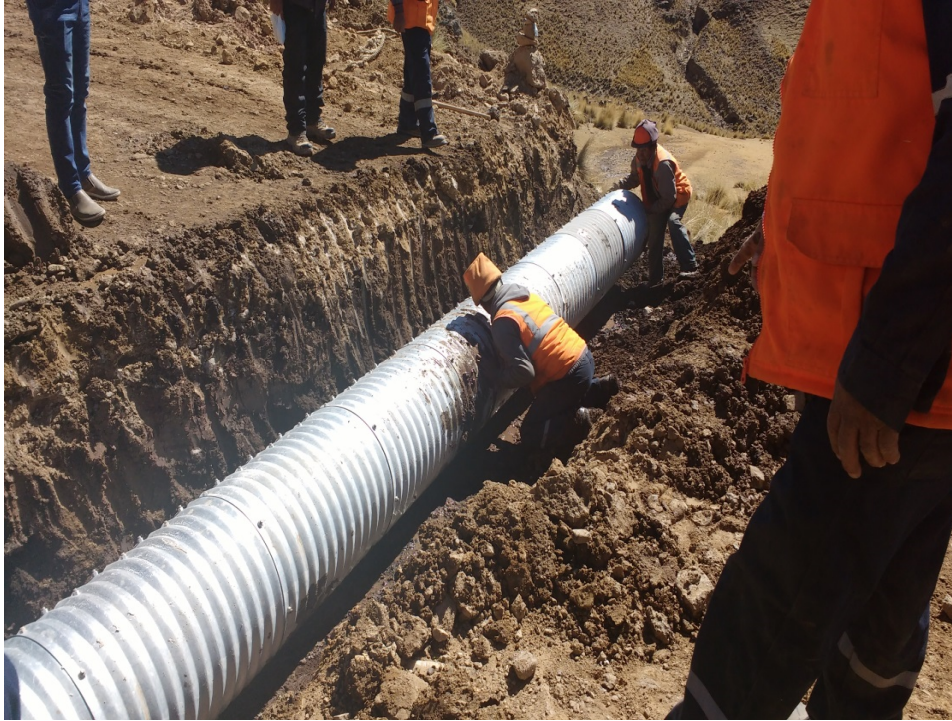
COLOCACION DE ALCANTARILLAS
