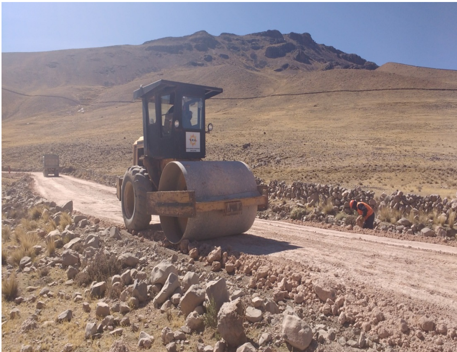
SEÑALIZACION PARA TRABAJOS DE LA CARRETERA
