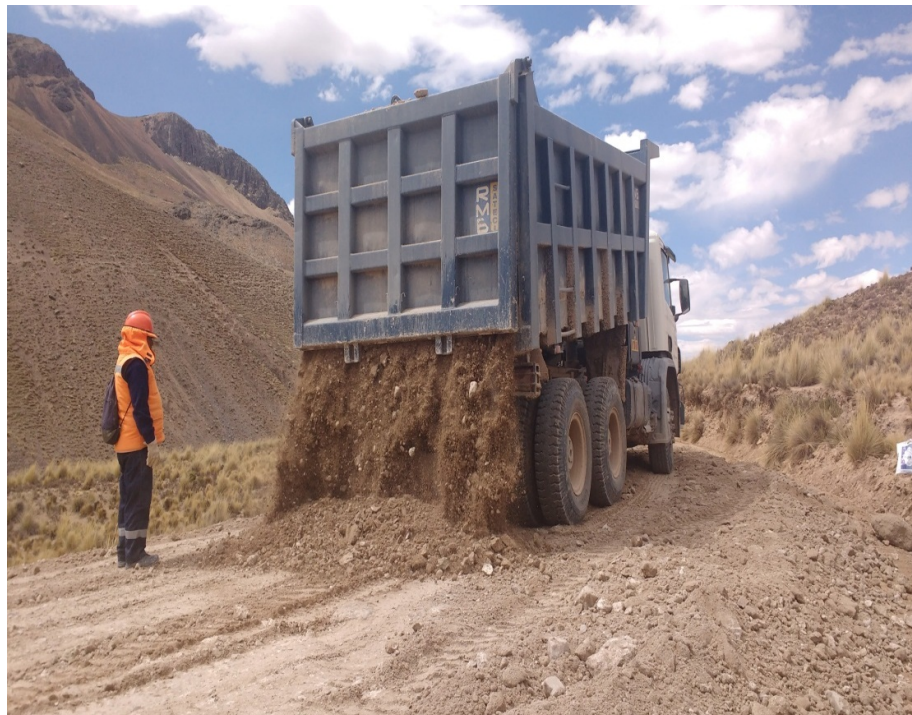
PERFILADO FINAL DE LA CARRETERA
