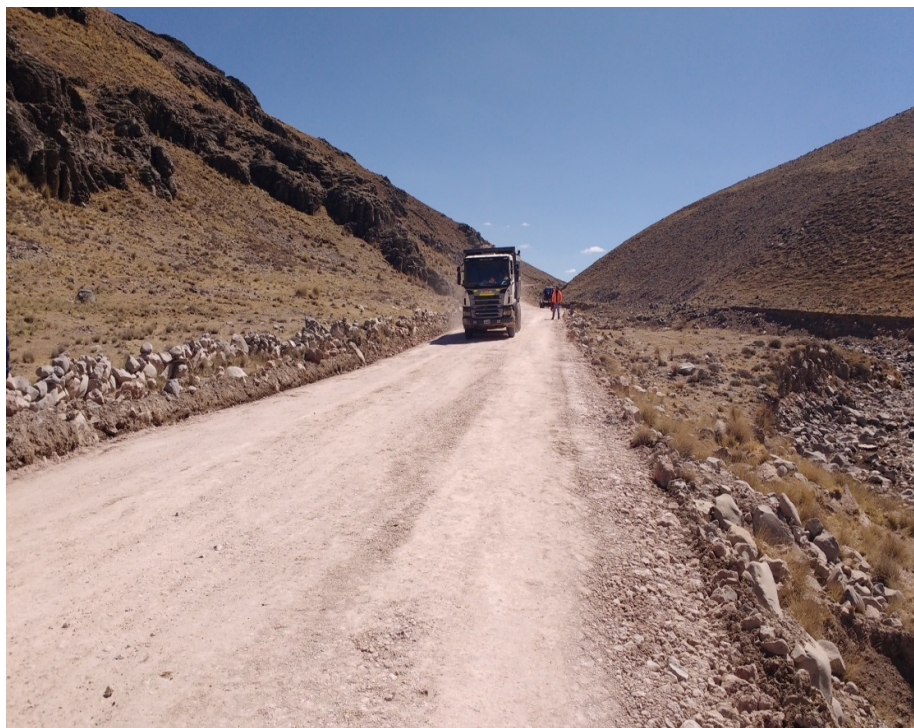
TRASLADO DE MATERIAL PARA AFIRMADO
