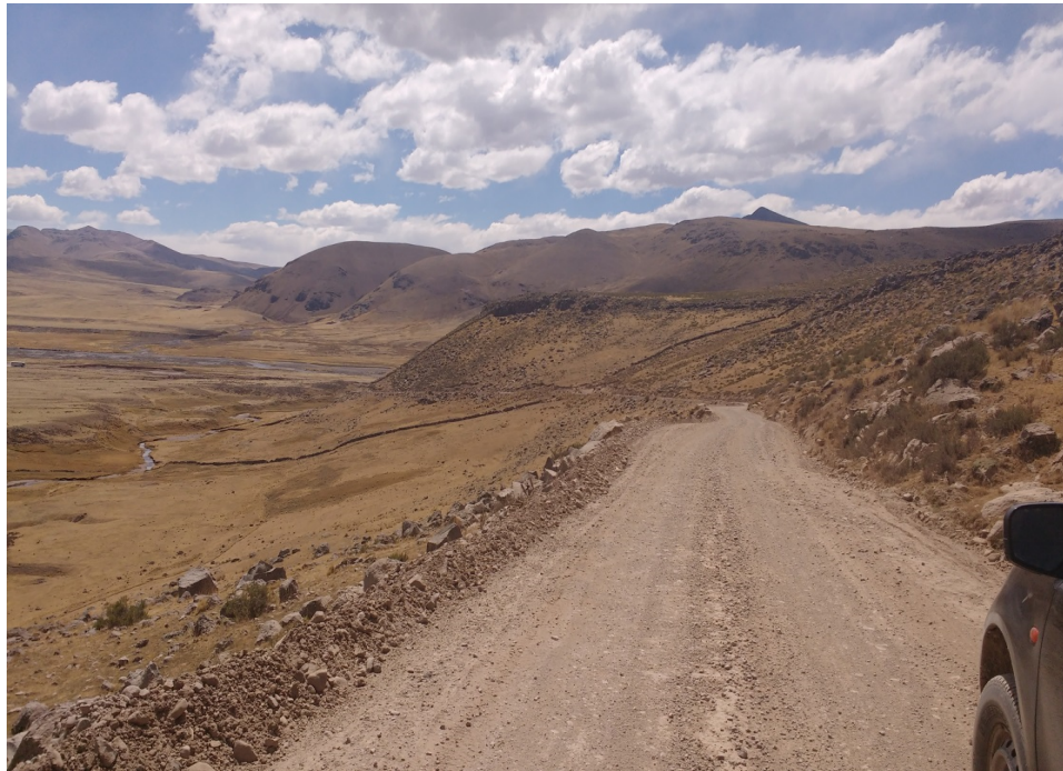
VERIFICACION DE PLATAFORMA EN LOS TRAMOS
