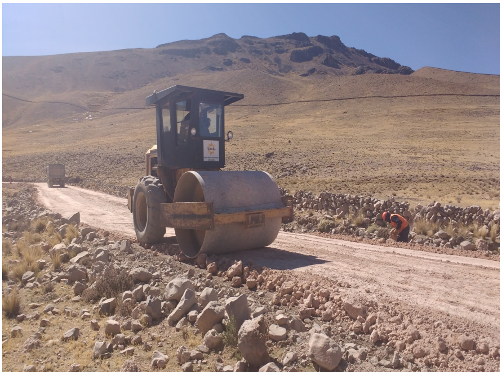
COMPACTACION DE PLATAFORMA
