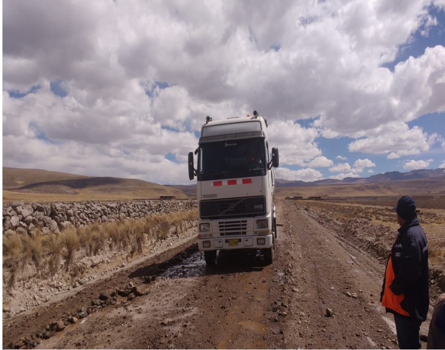
CONFORMACION DE CUNETAS NO REVESTIDAS
